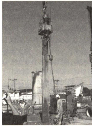
鋼製矢板打込み状況
