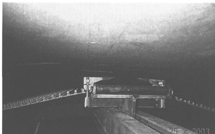
Photo. 9 ワンタッチリフトにより防食シートの引きこみ
