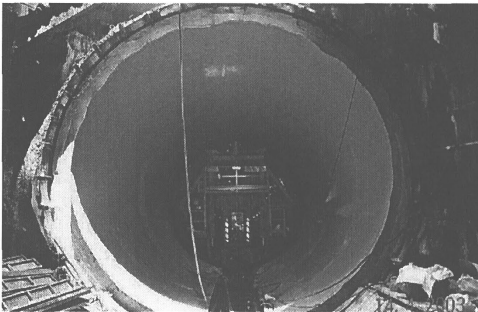
Photo. 4 二次巻き完了 (アーチ部) (インバート部のコンクリートは後打ち)
