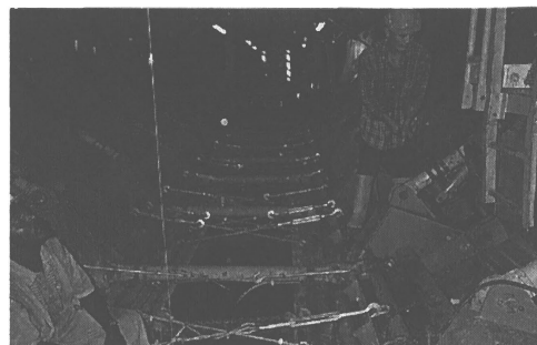
Photo. 12 防食シートテンションシステム (シート端末に特殊金物装着する)
