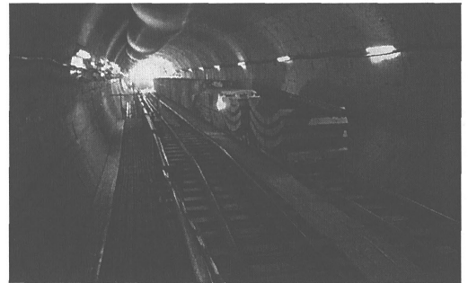
Photo. 2 立坑複線部で入坑を待っているローリングストック
