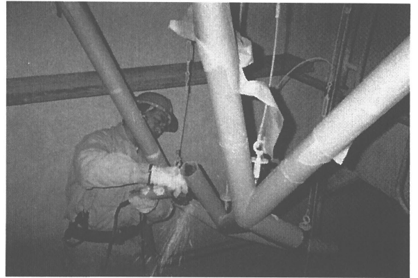
Photo-15 センターフレーム取付
