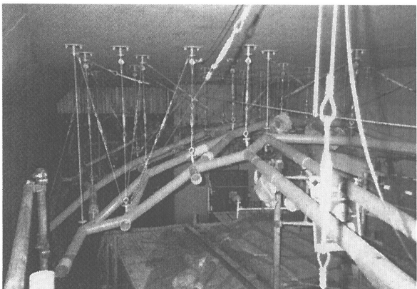
Photo-18 ウェブフレーム取付状況(2)
