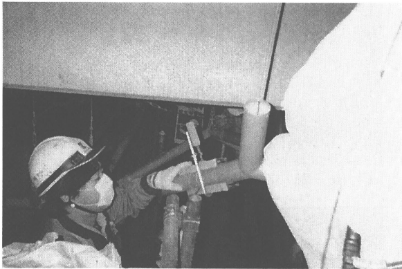
Photo-14 ジョイントサヤ管取付
