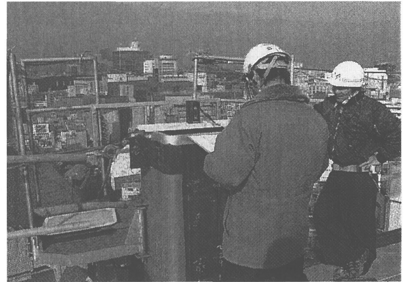
Photo3 柱天端での圧入速度管理
