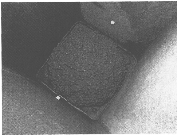
Photo5 圧入コンクリート天端状況
