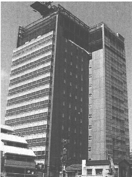
Photo1 全景写真（南西方向から、H14 年 6 月初旬撮影）
