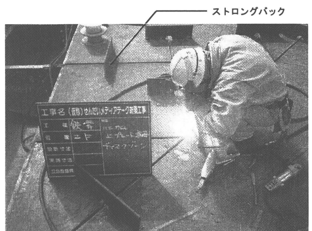
Photo. 8 プレート溶接
