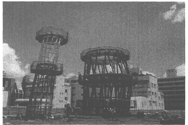
Photo. 3 チューブ建方完了
