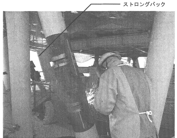
Photo. 6 ピース間の鋼管溶接
