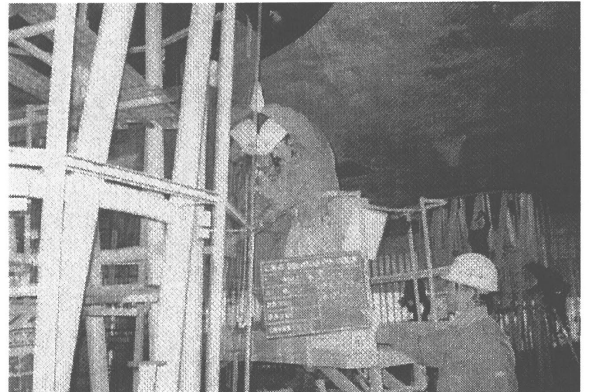
Photo. 9 チューブガラス取付
