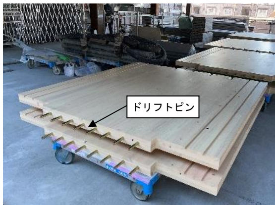
Photo. 8 CLT 材搬入状況
