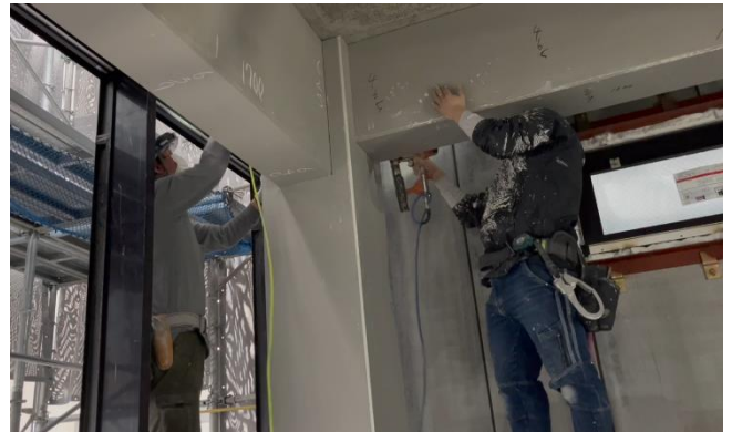
Photo. 5 耐火被覆層施工状況（貼り付け）
