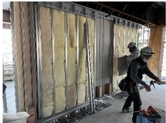
Photo. 11 遮音壁（反対面）施工状況
