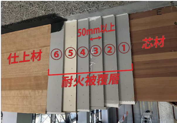
Photo. 7 λ-WOOD 施工状況
