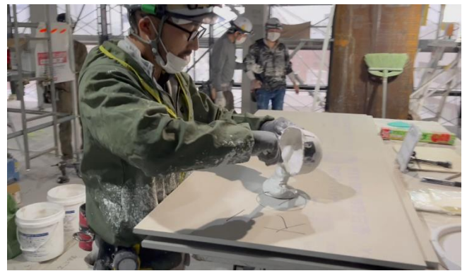
Photo. 4 耐火被覆層施工状況（接着剤塗布）
