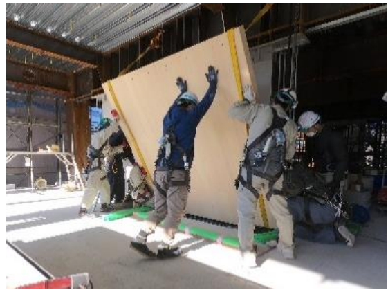
Photo. 10 CLT 壁建込み状況
