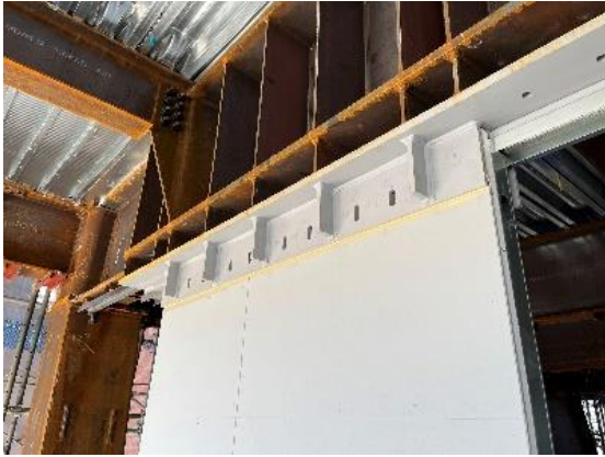
Photo. 13 タイガーUタイト充填状況
