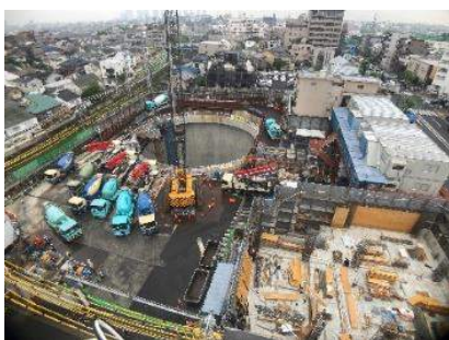
写真-9 ポンプ車・生コン車配置状況
