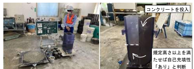
写真-3 充填性試験状況
