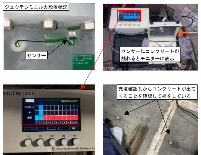
写真-8 ジュウテンミエルカと充填確認孔
