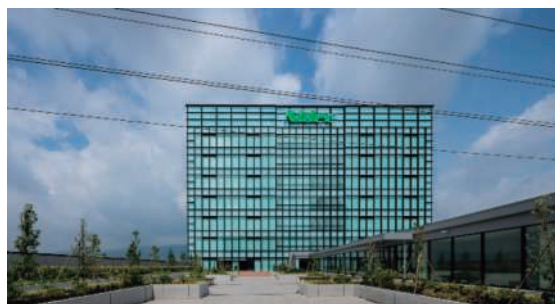
Photo. 2 低層棟 4階屋上
