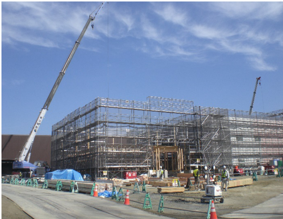
写真15 管理棟 木軸建方状況
