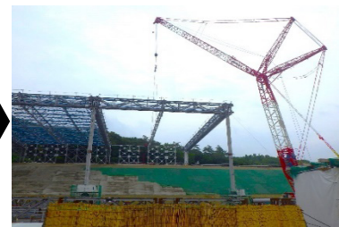
写真4 60mシングルトラス梁架け
