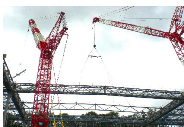
写真6 シングルトラス梁架け
