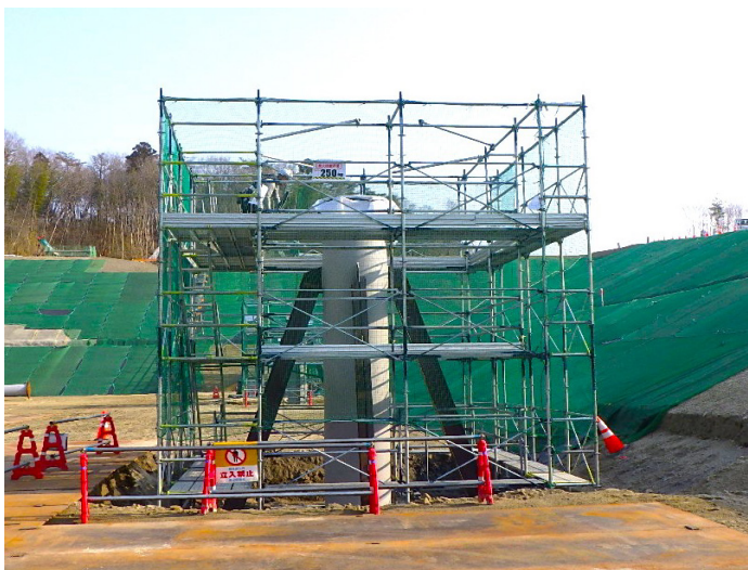
写真10 中間柱 転倒防止仮設取付完了
