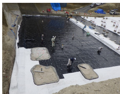
写真16 浸出水処理施設棟 遮水シート施工状況
