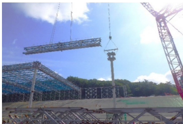
写真2 中間柱 ダブルトラス梁架け
