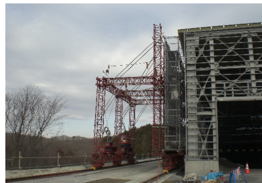
写真14 外壁用移動式足場
