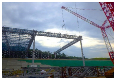
写真3 60mダブルトラス梁架け
