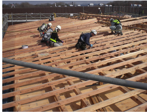
写真15 管理棟 木軸建方状況
