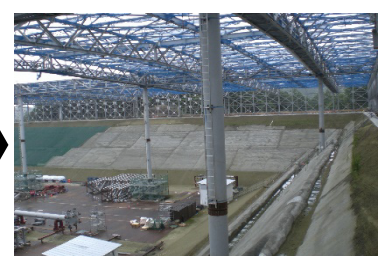
写真7 2-2工区鉄骨建方完了
