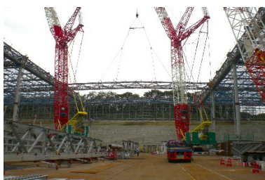
写真5 中間柱間 ダブルトラス梁架け
