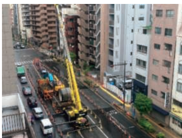
Photo.1 国道規制作業
