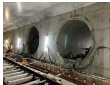
Photo.3 折返し線側ずい道
