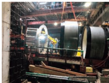
Photo.2 推進管投入作業
