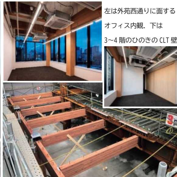
Photo.2 木造架構部施工状況
