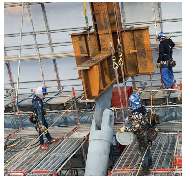
仕口建方状況
