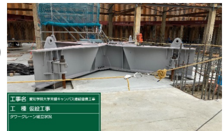
タワークレーン架台設置状況
