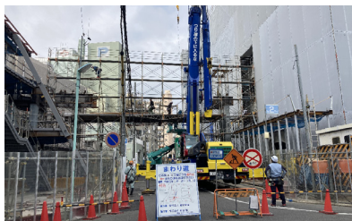
上空通路足場設置状況
