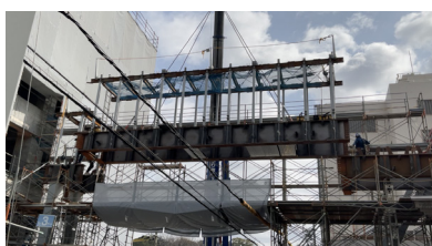
上空通路建方状況
