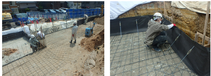
ワイヤーウォール施工状況
