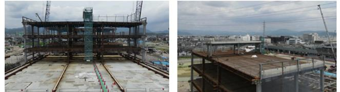
Photo. 13 1工区建方及び最上階パラペットPCa設置状況
