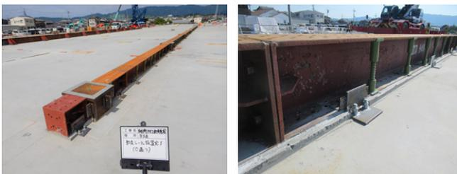
Photo. 11 軌条桁セット及び下部無収縮モルタル充填状況
