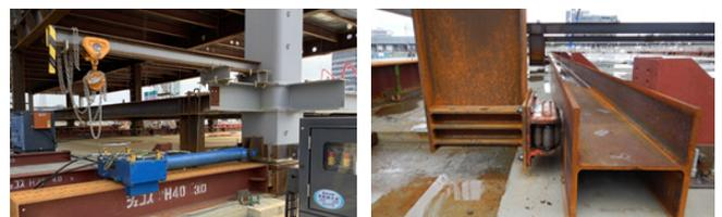
Photo. 16 水平ジャッキ・ガイドローラー設置状況
