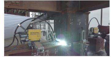
Photo. 21 溶接ロボットによる柱脚部溶接状況
