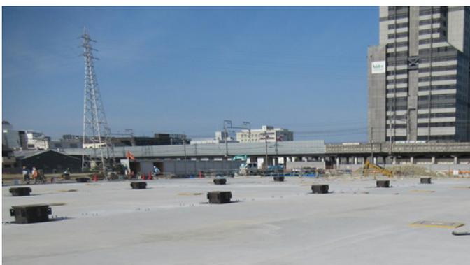
Photo. 3 柱脚ピース設置状況
