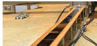
軌条桁上に SUS 板を溶接び両面テープで貼り付ける。熱伸びを考慮し、各 SUS 板間のすきまは 2mm 程度とした。
