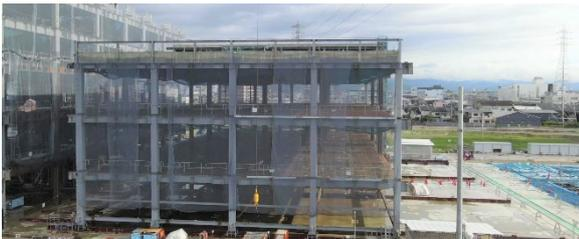
Photo. 19 2 工区鉄骨建方完了状況
