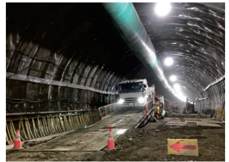
写真-1 90 度回転式車輪搭載型インバート栈橋
