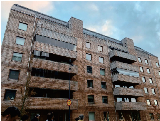
写真-3. 建物全景
