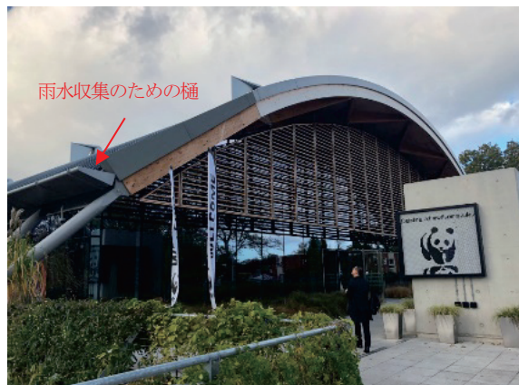
写真-5. 建物全景
