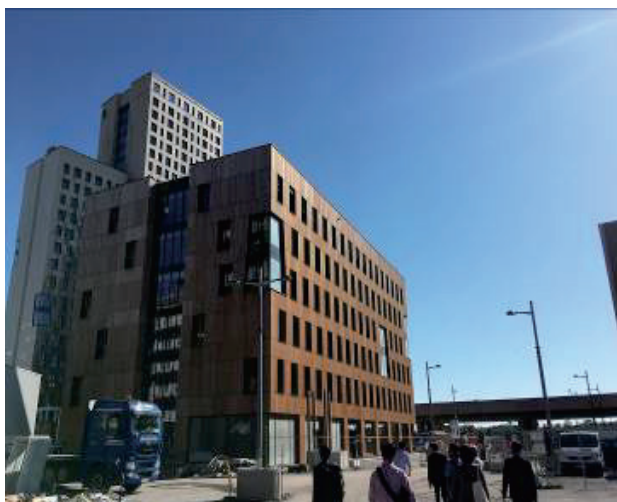
写真-10. 建物全景
