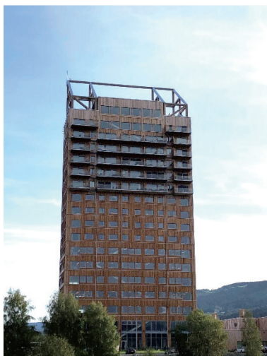
写真-14. 建物全景
