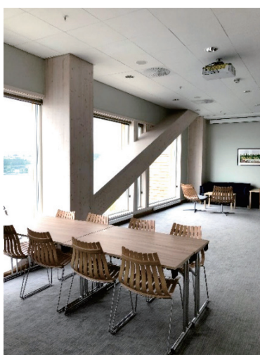
写真-15. 内観 (ブレース)
